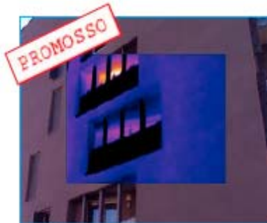
Dettaglio facciata nord-est
