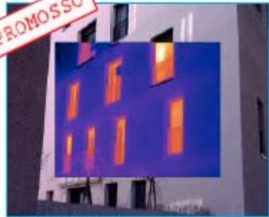
Dettaglio facciata nord-est
